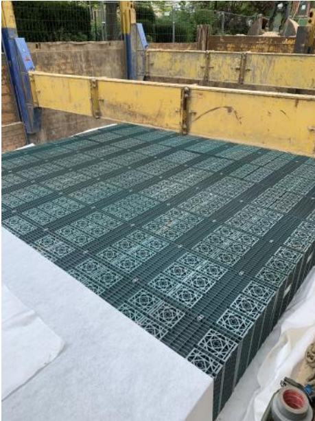
Bau der Rigolen in St. Joseph
