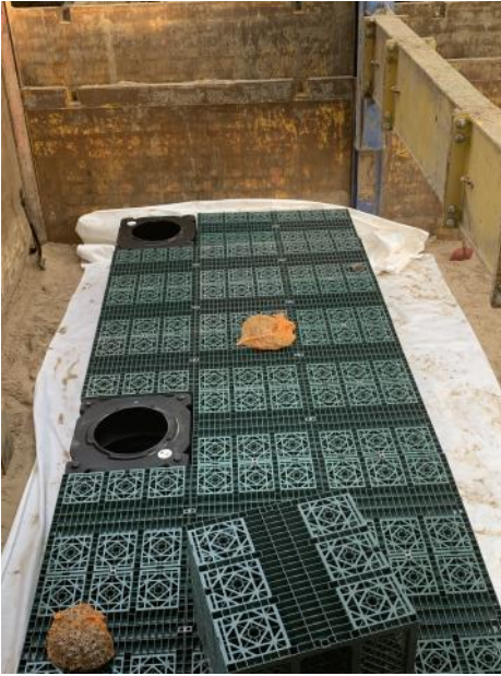
Bau der Rigolen in St. Joseph
